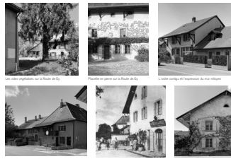
Exemples de façades de bâtiments existants
