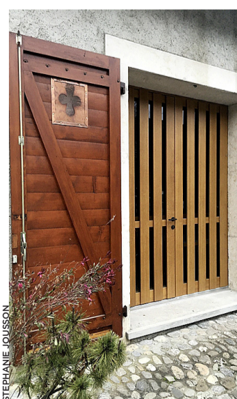
Une des portes du local.
