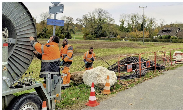
Les techniciens œuvrent au déploiement du réseau à Corsier. PATRICK JEAN BAPTISTE
